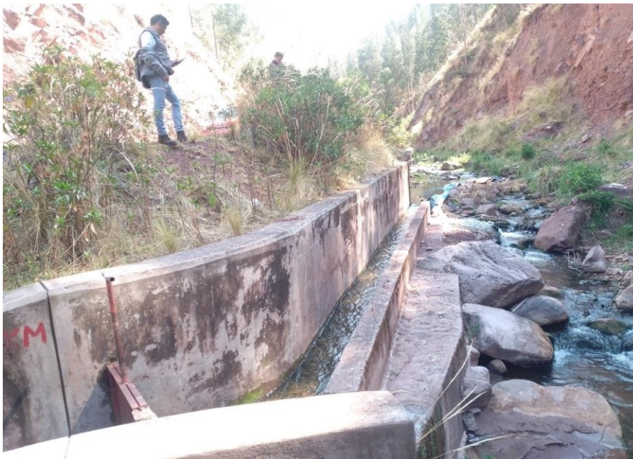
FIGURA N°03: EN LA TEMPORADA DE MAXIMAS AVENIDAS, AFECTA A LA BOCATOMA INCAONA CON SOCAVAMIENTO POR LA MARGEN DERECHA Y DE IGUAL FORMA SU TALUD ESTA DEBILITADO DE CAUCE MAS ARRIBA DE BOCATOMA
