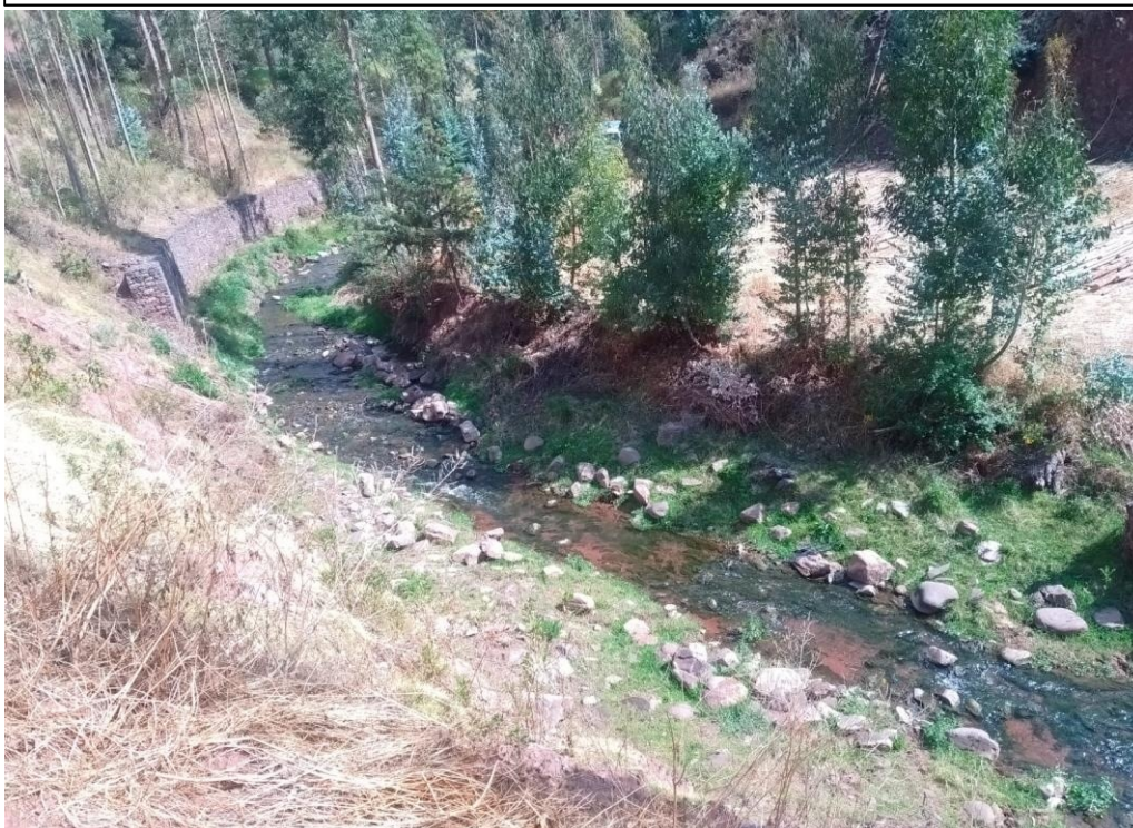
FIGURA N° 02: CAUCE DE RIO YAUQUISQUE EXPUESTO ANTE UNA SOCAVAMIENTO Y CONBARRERAS NATURALES Y MURO DE GAVION.
